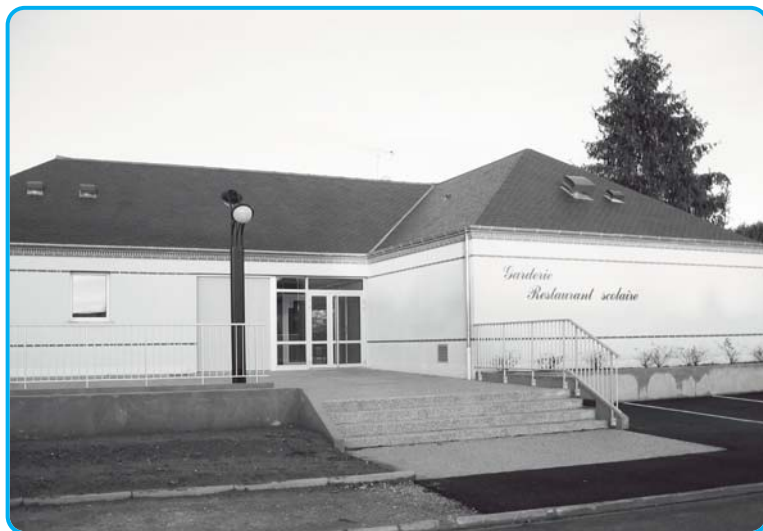
Achèvement des travaux de la Garderie et du Restaurant scolaire
